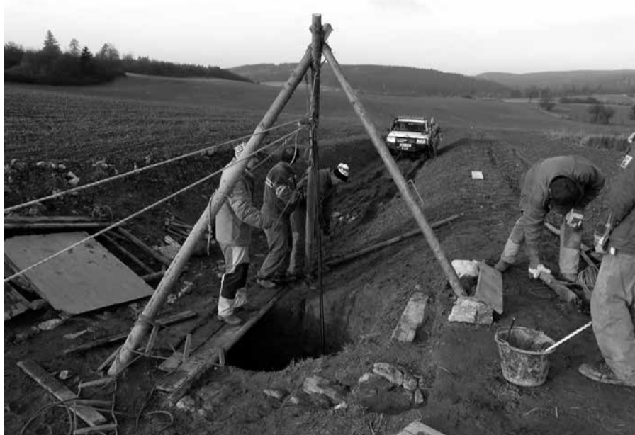
Foto 4 Ponor Kristýnka – hloubení druhé šachty
