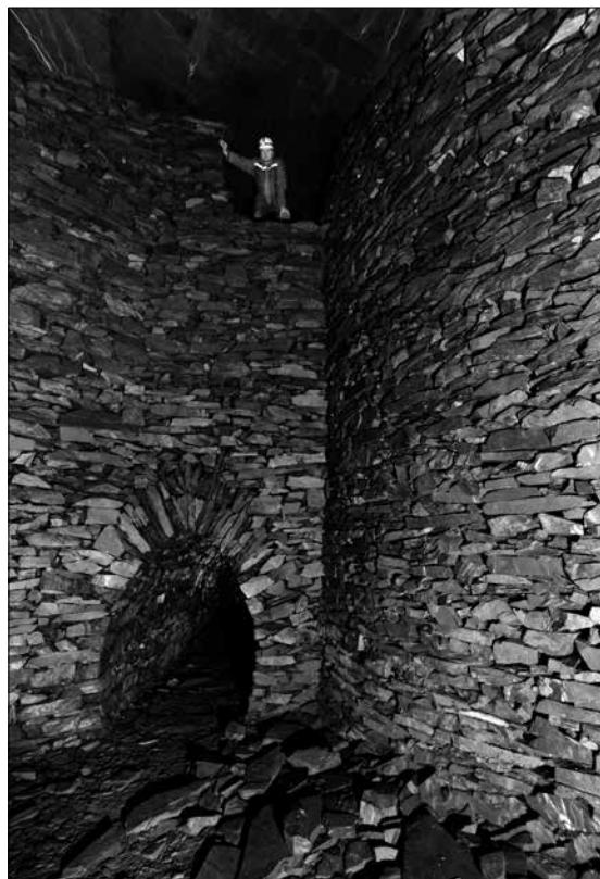
Foto 2 Vystavěná komora s gotickou chodbou, důl Nový svět (Foto J. Wagner)
