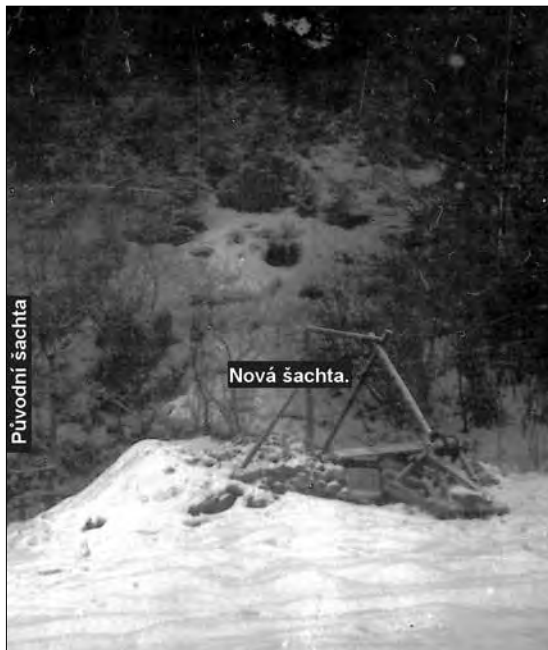
Foto 2 Nová šachta průvanů, prosinec 1966 (Foto L. Vojtenko)
