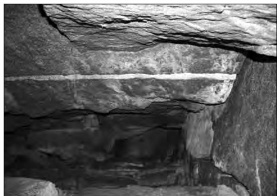
Foto 2 Dobře patrné obrysy vrtů v hlavní rozsedině (Foto J. Kukla)
