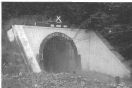
Obr. 3. Ústí překopu z Cavnice (foto R. Brandstetter, 1997).
