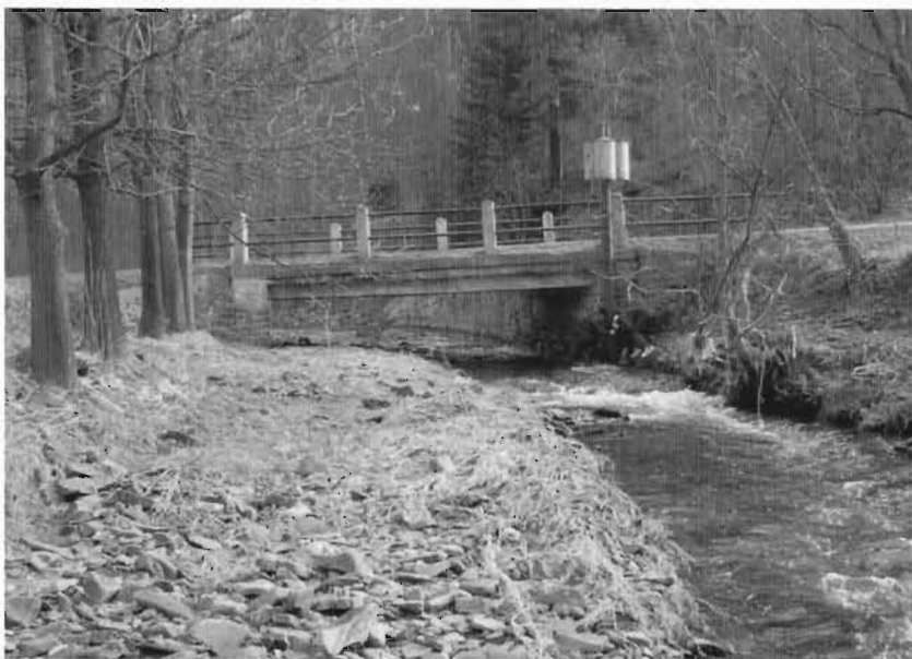
Vodoměrná stanice Holštejn – prohloubené koryto a pohled na rozměry transportovaných valounů (foto I. Dostál, duben 2005).
