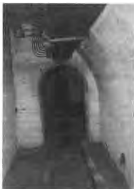
Obr. 5: Mezi rozvodnou a velkým sálem. Fig. 5: Between the grid and the big hall.
