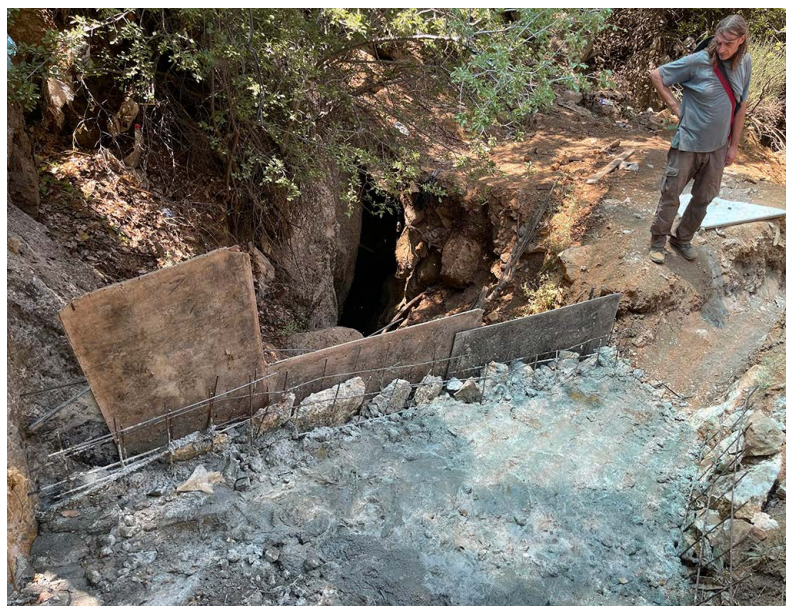
Foto 4 Nové koryto se začíná rýsovat (foto M. Hejna)
