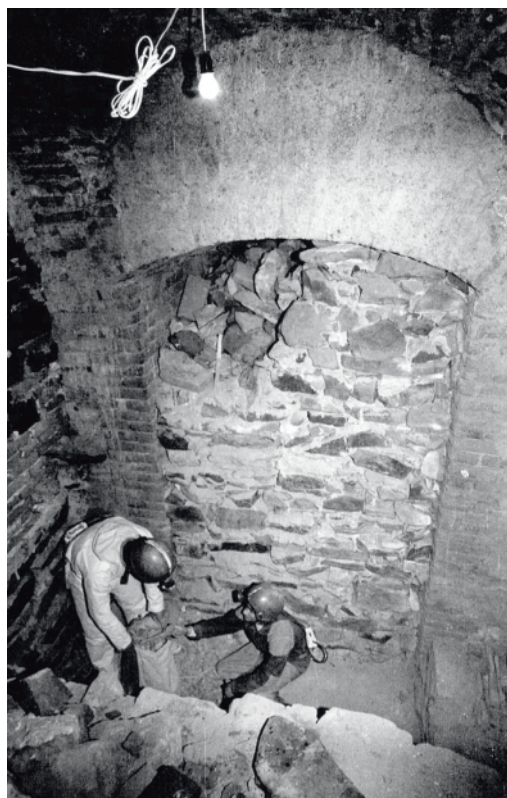
Foto 7 Krypta pod věží – ossarium v průběhu vyklízení kostí. Na fotografii je dobře patrná naddimenzovaná zazděná hlavní přístupová chodba, směřující do zazděných sklepení pod terasou schodiště. Tudy odcházeli řemeslníci zazdívající v pol. 18. století kryptu. (Foto M. Šenkyřík 1991)
